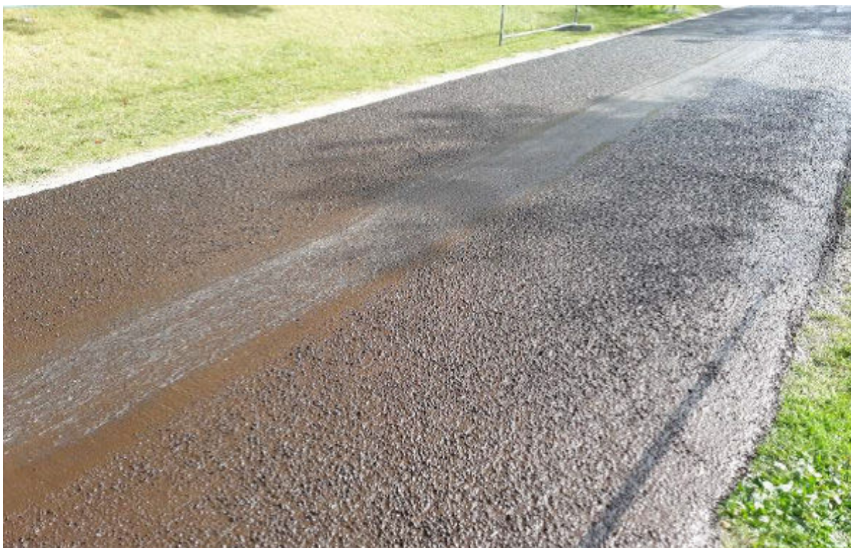
40. att. MS ieklāšana uz ļoti nelīdzenas virsmas – pēc otrā gājiena
