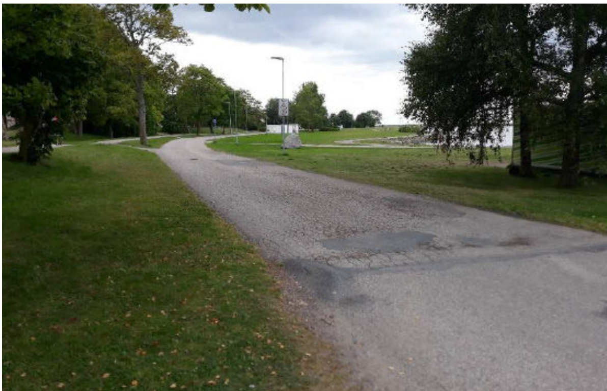
28. att. Posma sākums ar skatu no Pargi virzienā uz Lossihoov
