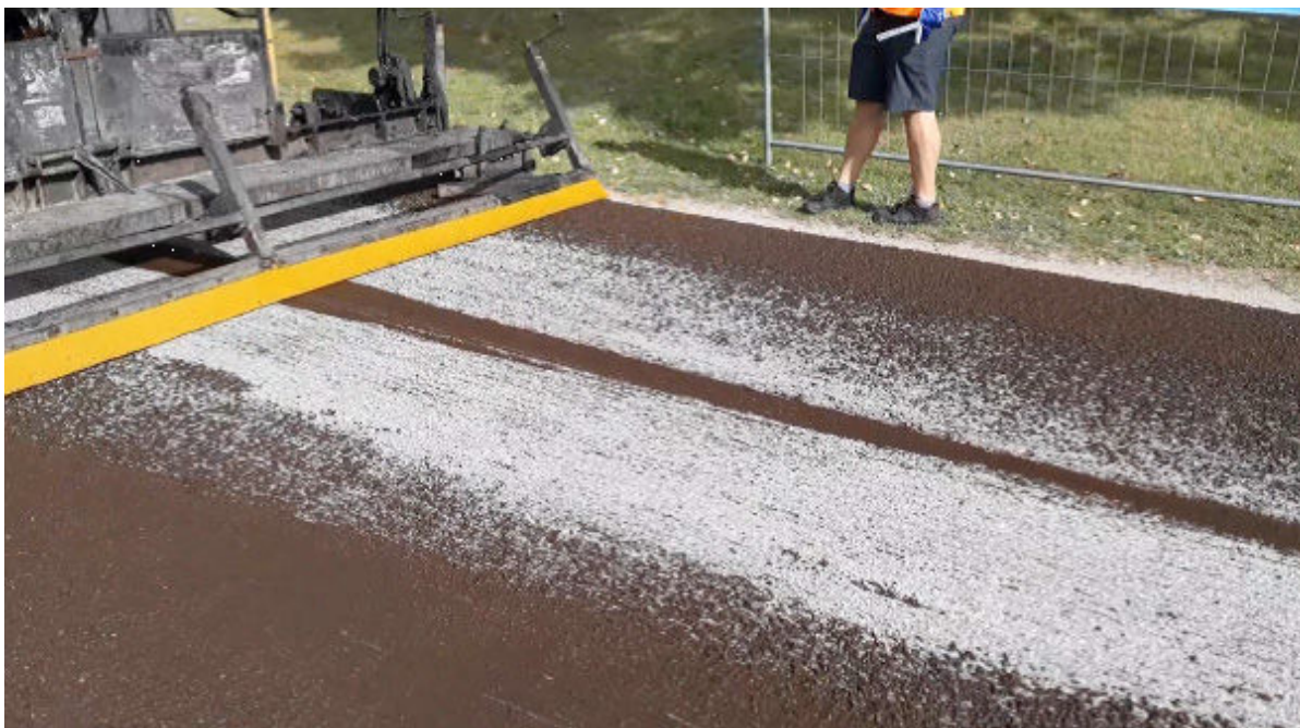
39. att. MS ieklāšana uz ļoti nelīdzenas virsmas – pirmais jeb sākotnējais gājiens
