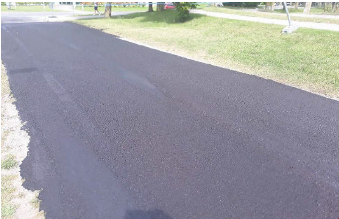
43. att. Ieklātā MS izlīdzinošā kārtā
