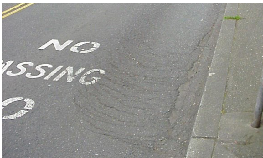
20. att. Seguma nobīde jeb slīdēšana [9]
