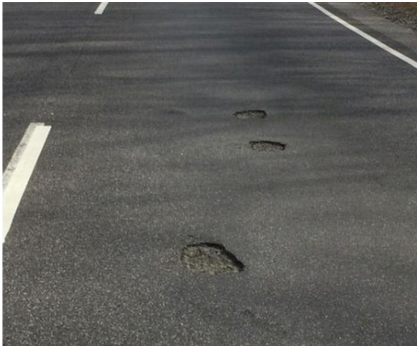
17. att. Slurry seal atslāņošanās ( https://slideplayer.com )
