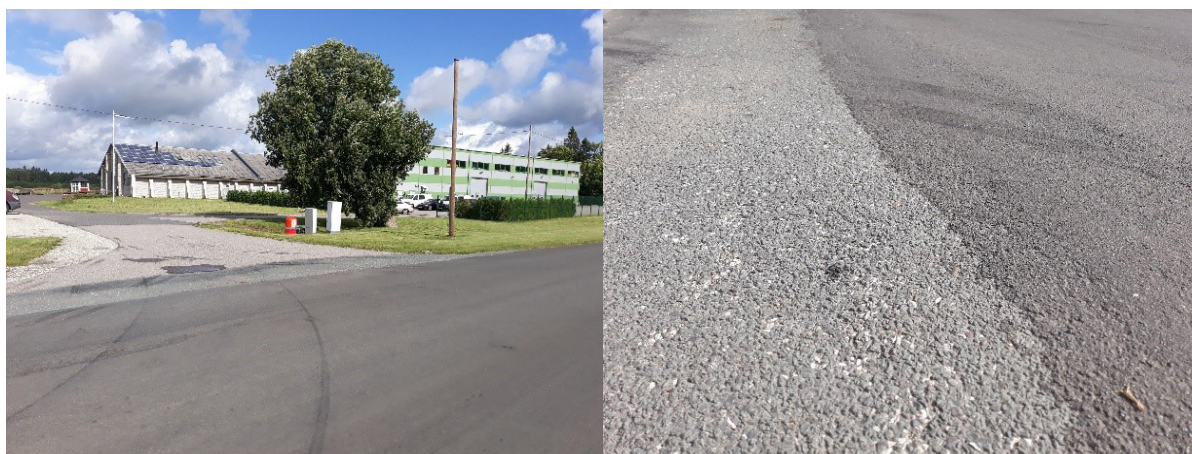
47. att. Autoceļa ar MS segumu savienojums ar iebraucamo ceļu ražotnes teritorijā
