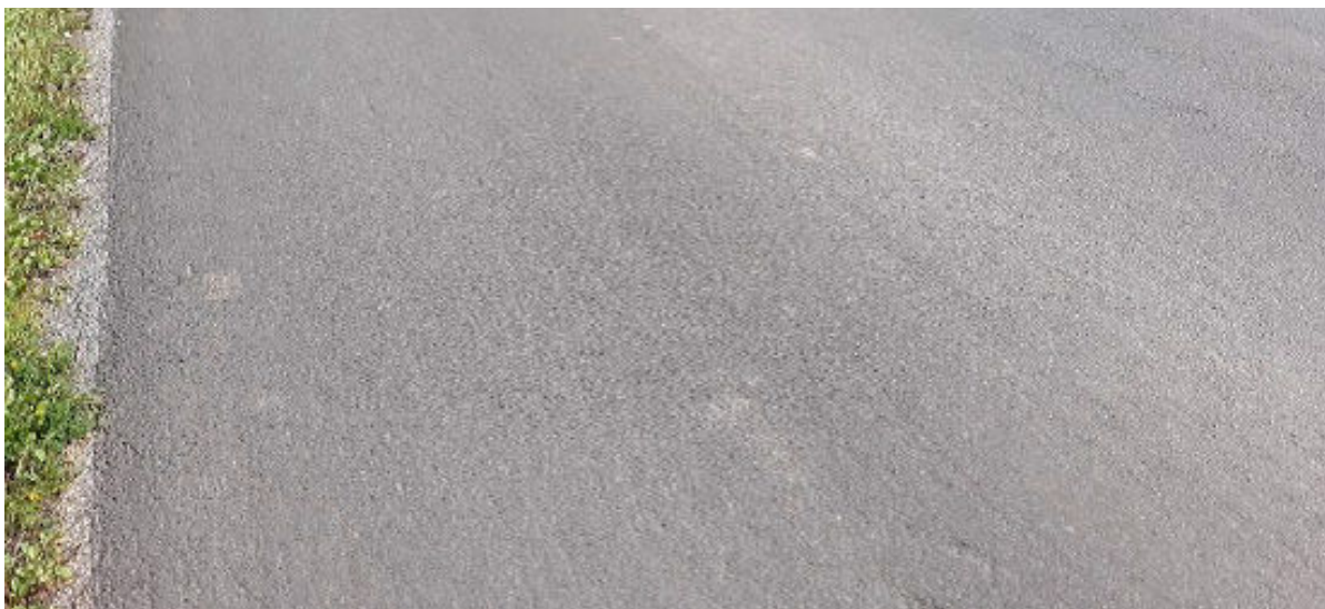
48. att. MS seguma stāvoklis pēc viena ekspluatācijas gada
