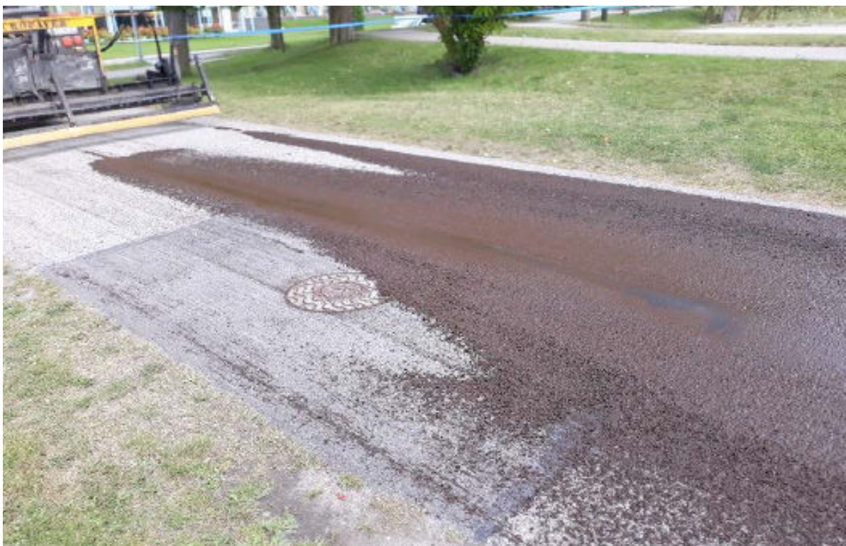
45. att. MS uzklāšana virs akas lūkas
