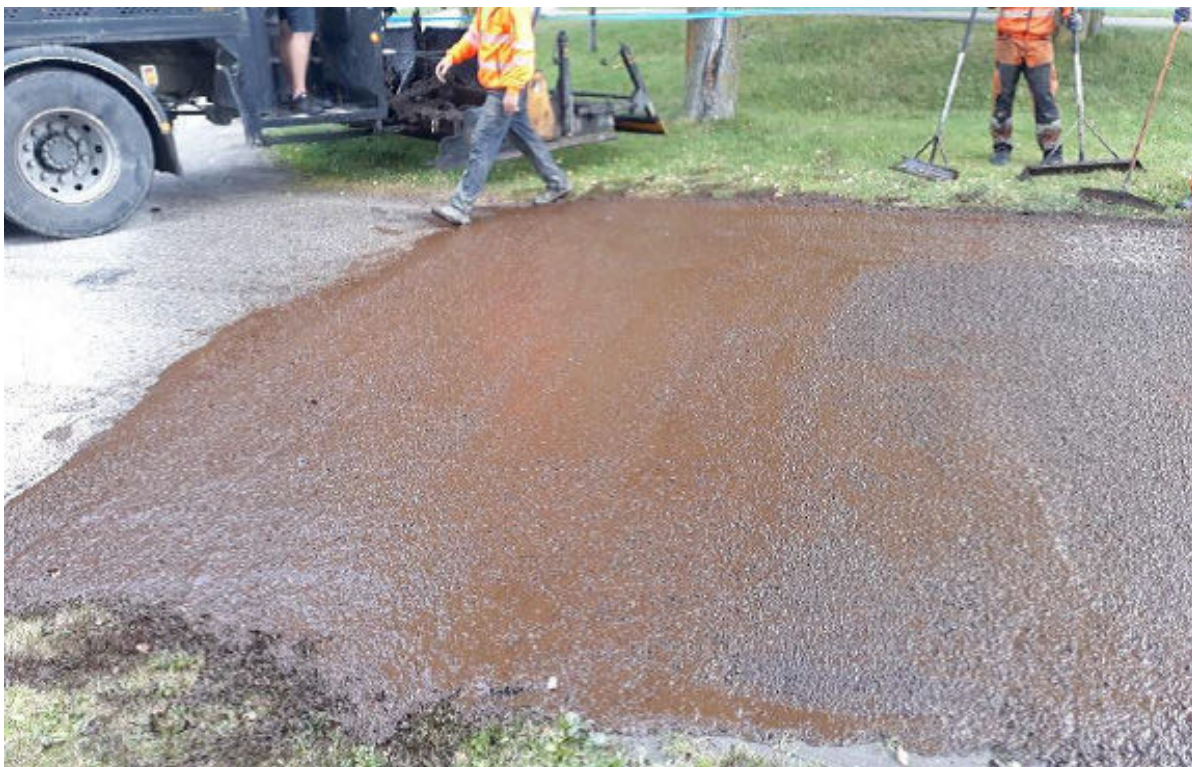
42. att. Posma ieklāšanas beigās izlīdzināšana tika veikta ar rokām
