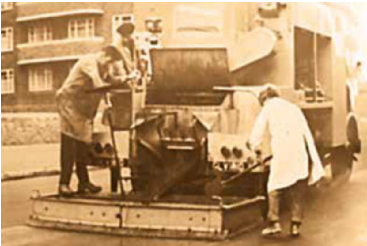
1. att. Slurry seal ieklājējs Rex Slurry Matic ( www.nouryon.com )
