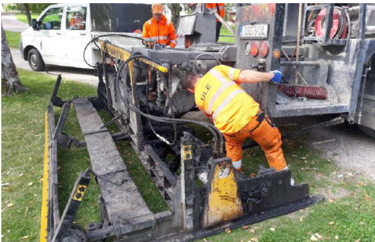
36. att. MS kastes (box) piestiprināšana pie mašīnas
