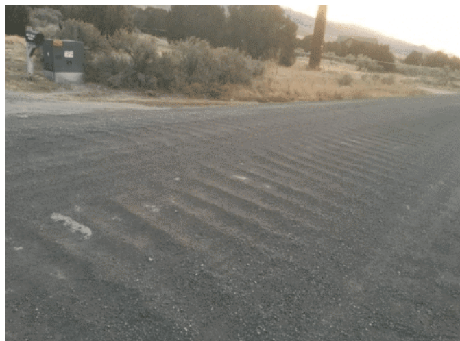
21. att. Šķērsvīļņošanās jeb rievu veidošanās ( http://www.pavemanpro.com )
