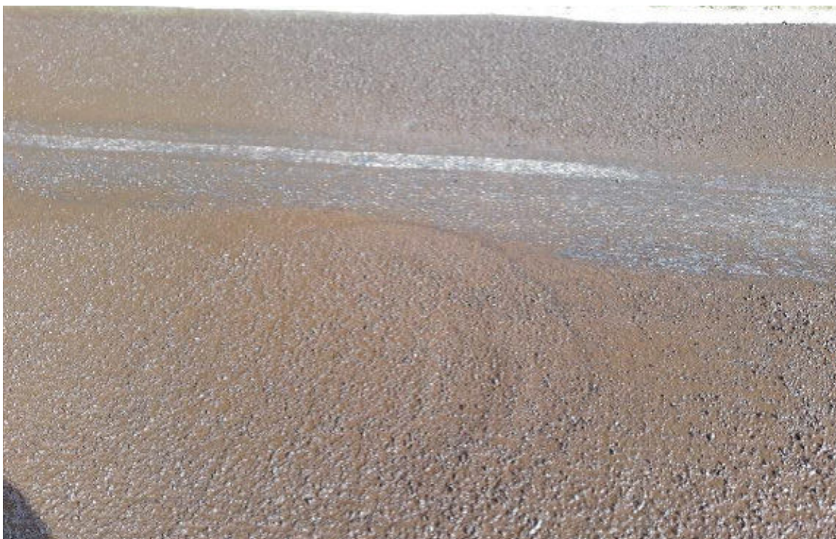
41. att. Aizpildīts lokālais bojājums
