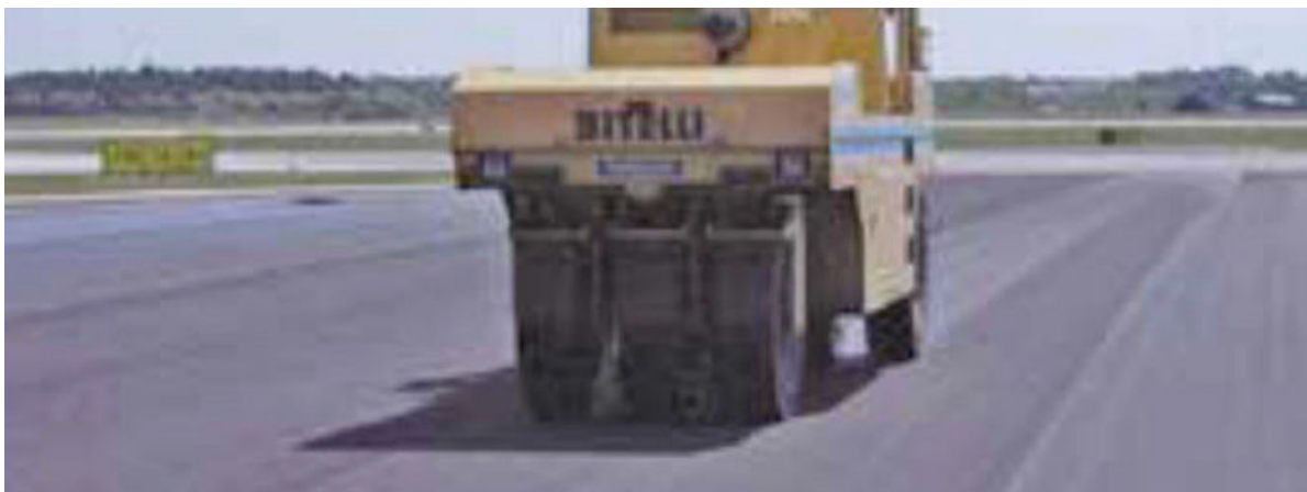
54. att. SS un MS sablīvēšana ar pneimatisko veltni
