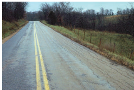
5. att. Asfaltbetona noguruma plaisas (aligatorplaisas): a) lokālas [2]; b) globālas [3]
