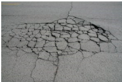
5. att. Asfaltbetona noguruma plaisas (aligatorplaisas): a) lokālas [2]; b) globālas [3]
