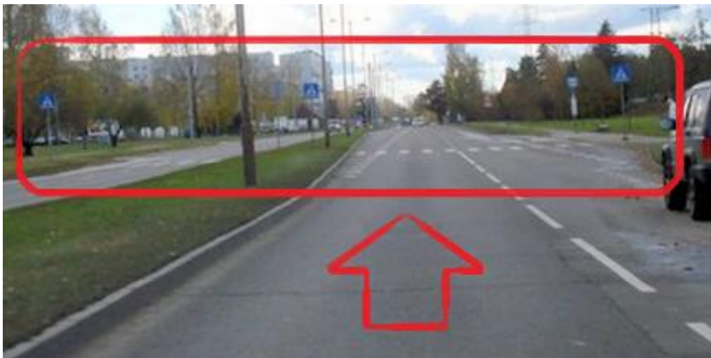
23.attēls. Gājēju pāreja, kas neatbilst LVS 190-10 4.1.1.punktam.
