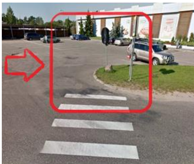
30.attēls. Gājēju pāreja, kas neatbilst LVS 190-10 5.1.punktam.
