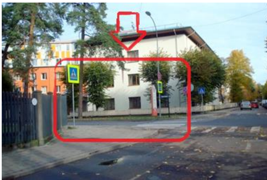
28.attēls. Gājēju pāreja, kas neatbilst LVS 77-2 6.6.18.punktam.
