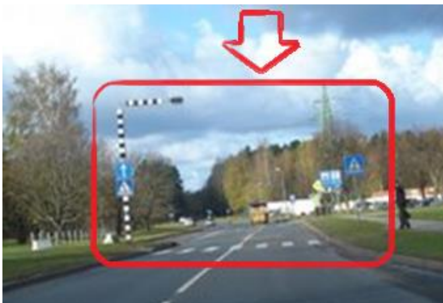
22.attēls. Gājēju pāreja, kas neatbilst LVS 190-10 4.1.1.punktam.
