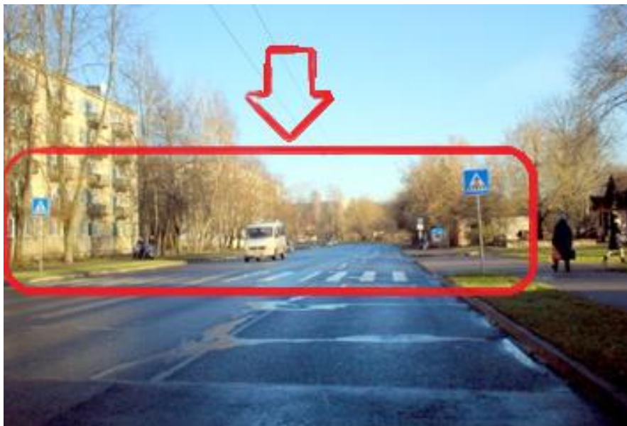
20.attēls. Gājēju pāreja, kas neatbilst LVS 190-10 4.1.1.punktam.
