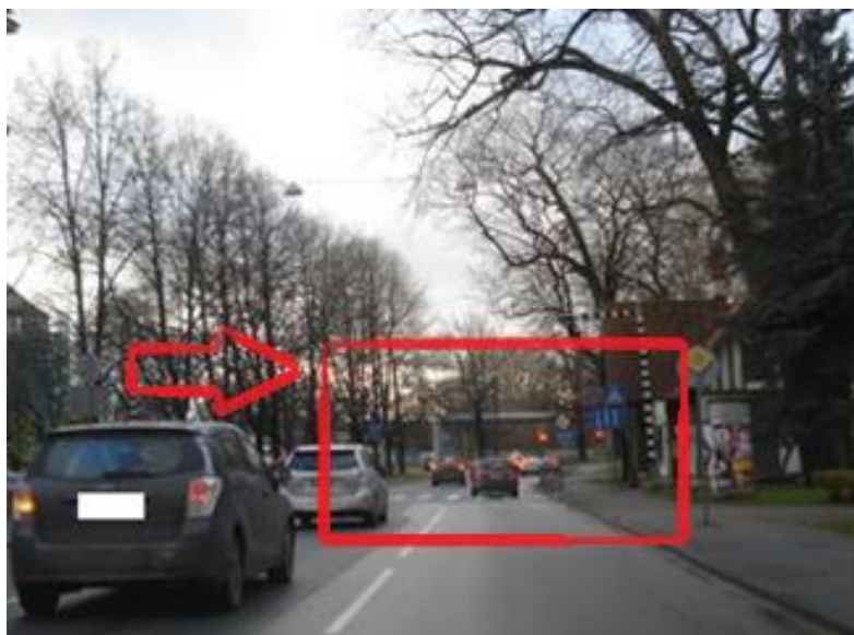
17.attēls. Gājēju pāreja, kas neatbilst LVS 190-10 4.1.1.punktam.
