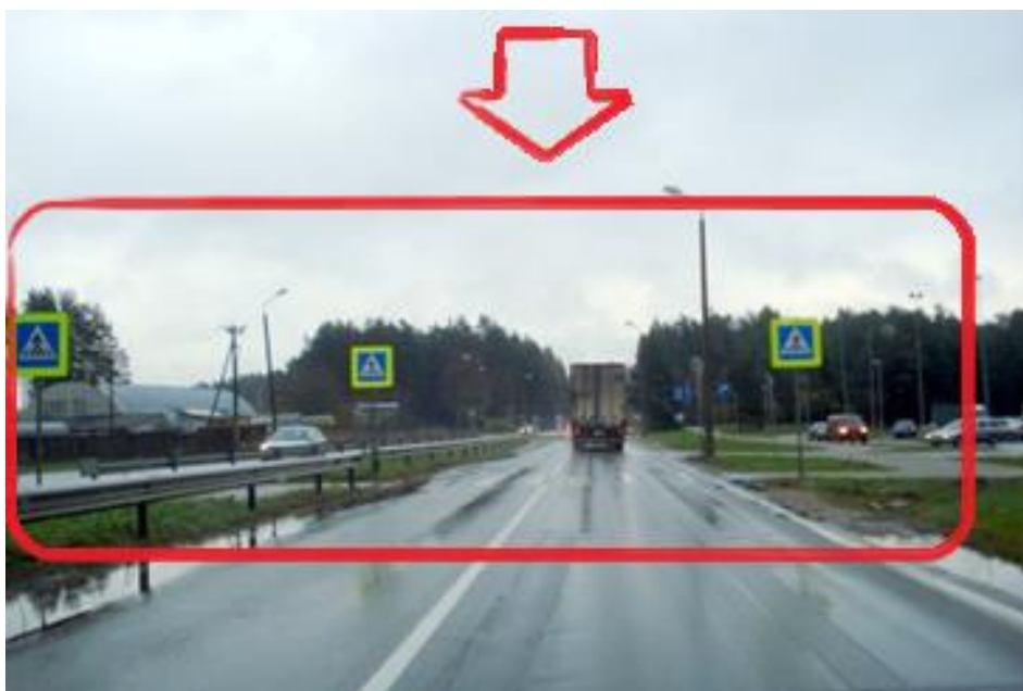
24.attēls. Gājēju pāreja, kas neatbilst LVS 190-10 4.1.1.punktam.
