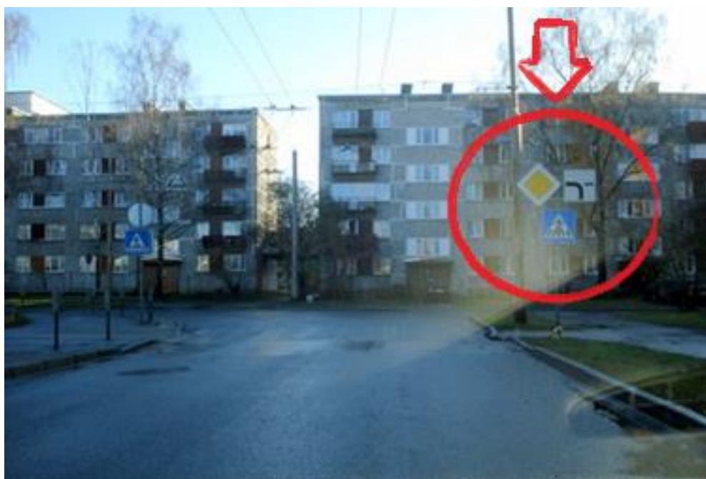
18.attēls. Gājēju pāreja, kas neatbilst LVS190-10 5.2.punktam.
