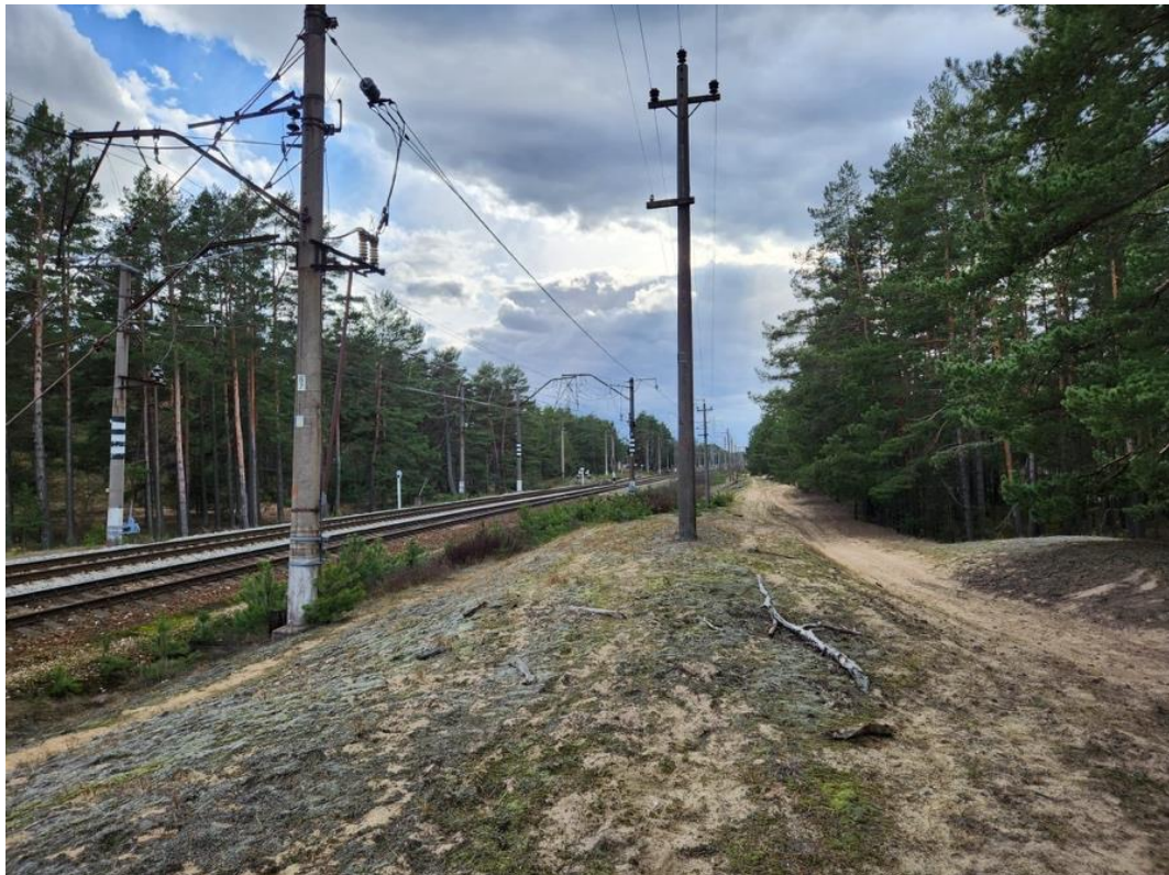
attēls 7.1., 7.2., 7.3. Fotofiksācijas no velosipēdu ceļa teritorijas (autoru uzņemtas)
