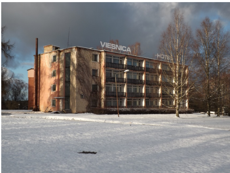
22. attēls. Bijušais III korpuss Kovārņu ielā 22 [130]
