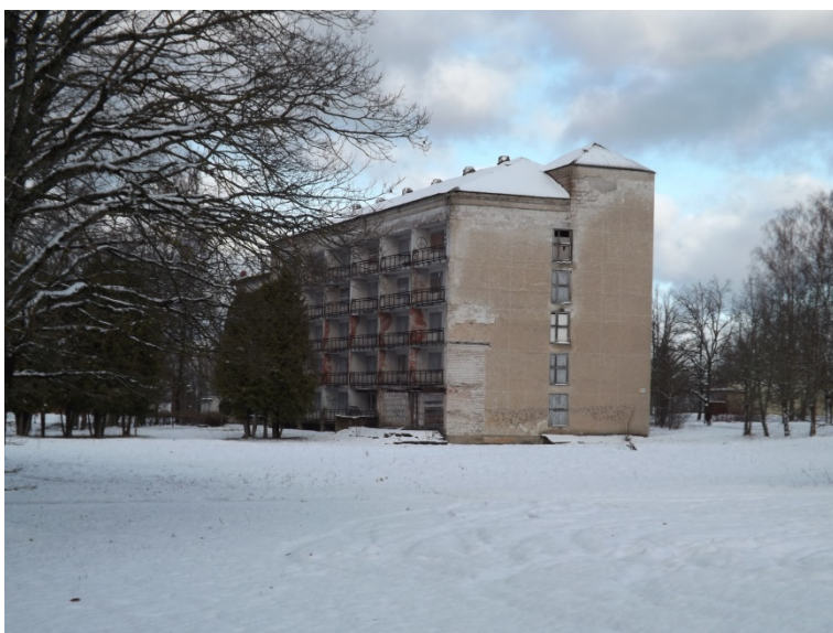
28. attēls. Bijušais I korpuss Kovārņu ielā 28 [130]
