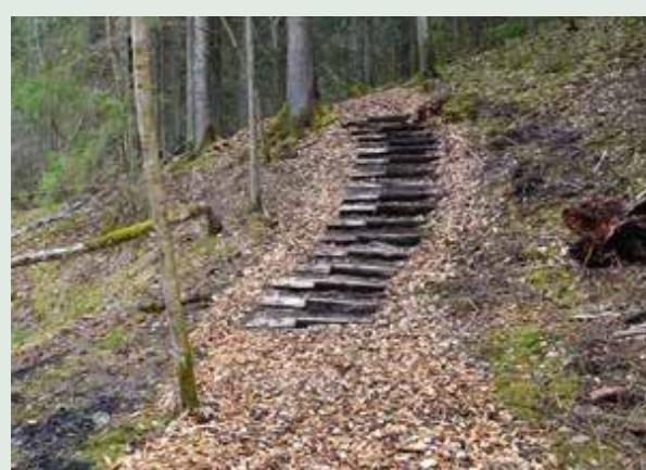
15.14. att. Nelielā slīpumā izveidotas kāpnes no koka šķilām, celiņam un kāpnu apkārtnei izmantota koksnes šķelda. Foto: S. Ikauniece.
