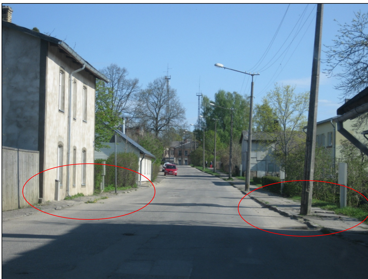
4. attēls. Gājēju ceļš sliktā stāvoklī.
