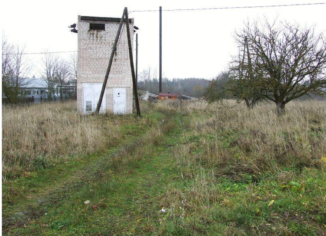
Attēls Nr. 73. Skats no Jaunatnes ielas Viļakā uz teritoriju DA virzienā
