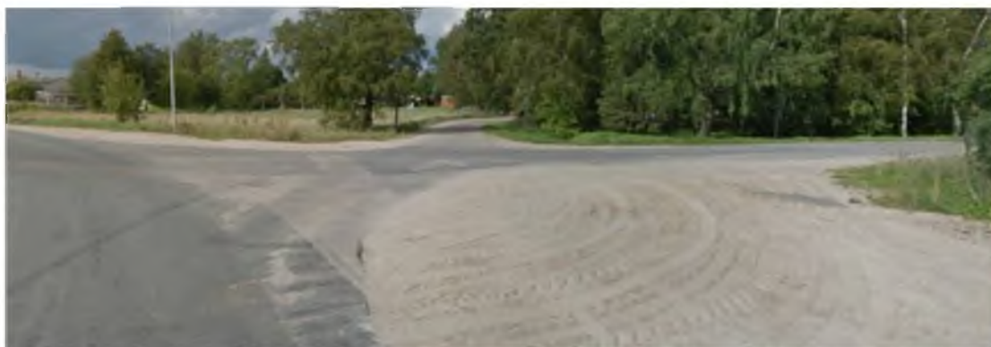
37. att. – Satiksmes/Stacijas ielu pieslēgums Kuldīgas ielai – mezgls atbilstoši Šeštoku metodei uzskatāms par ļoti bīstamu, paredzēta mezgla rekonfigurācija – Satiksmes iela pieslēdzama Kuldīgas ielai, bet Stacijas iela – Satiksmes ielai
