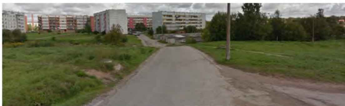
34. att. – Cieceres ielai raksturīga liela plāna un garenprofila līkumainība – nepieciešams veikt ielas rekonstrukciju, nosakot vienvirziena satiksmes organizācijas režīmu un paredzot jaunas gājēju ietves
