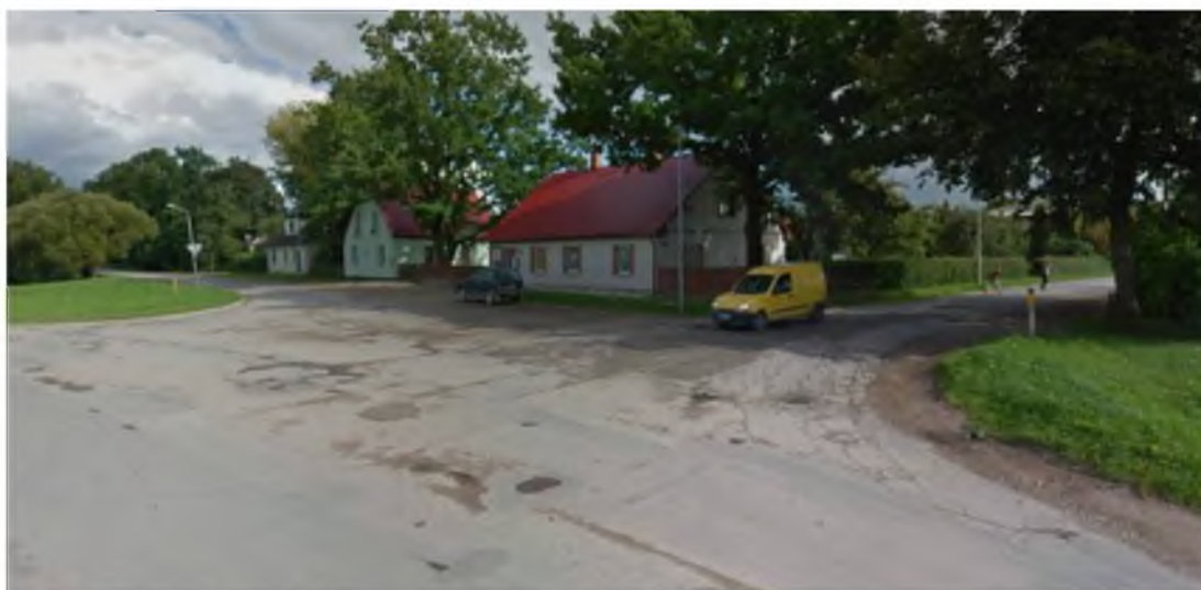
14. att. – Ganību/Līkās/Lielās ielas krustojums ar neskaidru satiksmes organizāciju un sliktu pārredzamību
