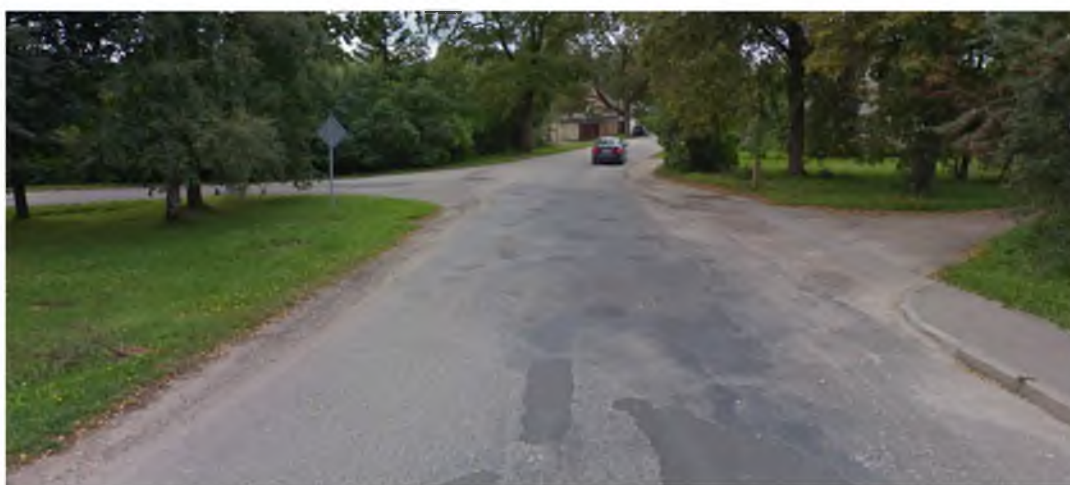
16. att. – Aspazijas ielas posms pie Kuldīgas ielas – ielas segums ir pilsētas nozīmes ielai neapmierinošā tehniskā stāvoklī
