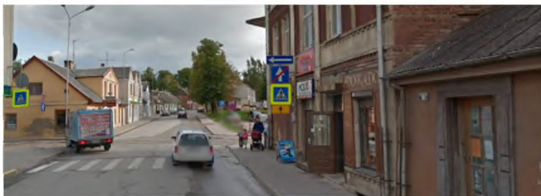
25. att. – Striķu/Rīgas ielu mezgls ar augstu bīstamību – lai samazinātu mezgla bīstamību, ieteicams Striķu ielas vienvirziena režīmu turpināt līdz Kapu ielai
