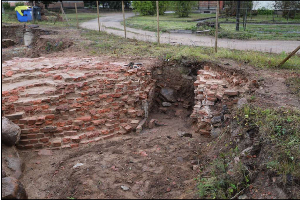
33.Foto. Augšdaugavas novads, Ilūkste. Bij. Ilūkstes Sv.Ursulas katoļu baznīca. Apsīdas daļas pamatu fragments un nezināmas pagraba telpas ieejas vieta baznīcas ārpusē pēc mūru attīrīšanas. Skats no DA.
