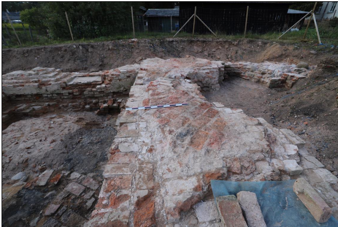
24.Foto. Augšdaugavas novads, Ilūkste. Bij. Ilūkstes Sv.Ursulas katoļu baznīca. Lokveidā mūrēti ķieģeļi telpas Z sienā. Skats no A puses.
