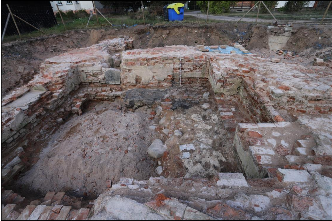
21.Foto. Augšdaugavas novads, Ilūkste. Bij. Ilūkstes Sv.Ursulas katoļu baznīca. Telpa aiz presbitērija pēc mūra konstrukciju pilnīgas attīrīšanas. Skats no Z.
