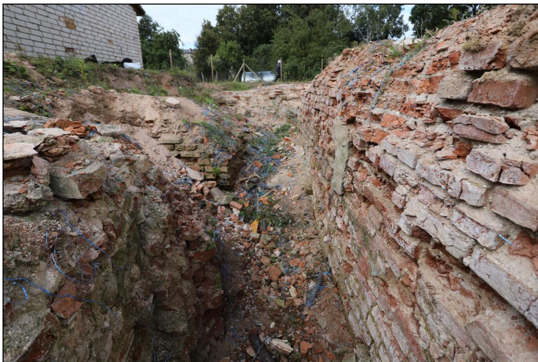
3.Foto. Augšdaugavas novads, Ilūkste. Bij. Ilūkstes Sv.Ursulas katoļu baznīca. Baznīcas pamati D daļā pēc pagaidu nojumes konstrukcijas demontāžas.
