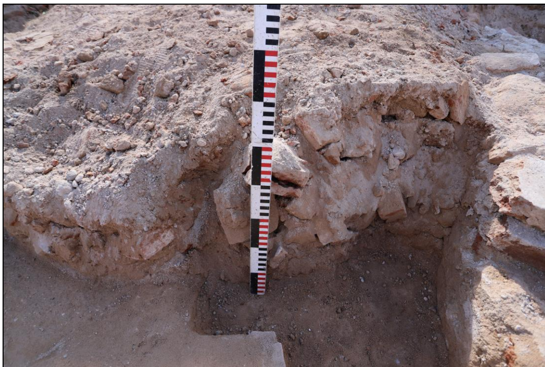
29.Foto. Augšdaugavas novads, Ilūkste. Bij. Ilūkstes Sv.Ursulas katoļu baznīca. Būvgružu uzbērumš pagraba noejas kāpņu vieta baznīcas apsīdas ZR pusē.
