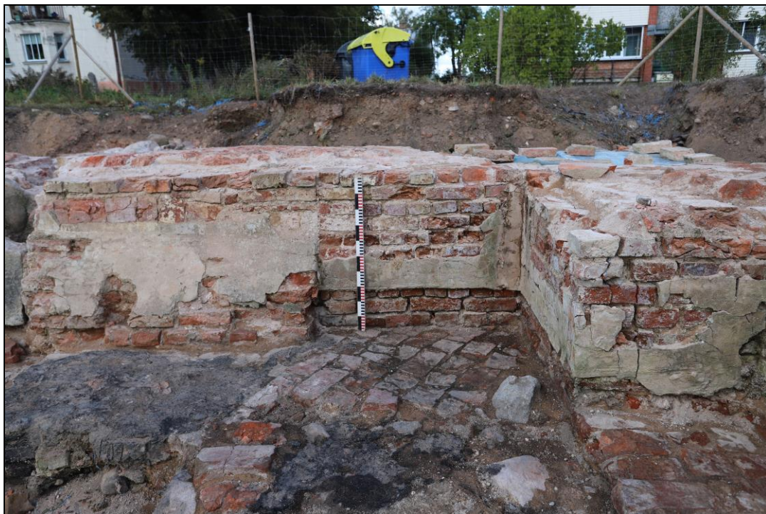
20.Foto. Augšdaugavas novads, Ilūkste. Bij. Ilūkstes Sv.Ursulas katoļu baznīca. Tas pats. Skats no Z. Pēc mūru attīrīšanas redzams telpas apmetums un ķieģeļu grīdas segums telpas ZA daļā.
