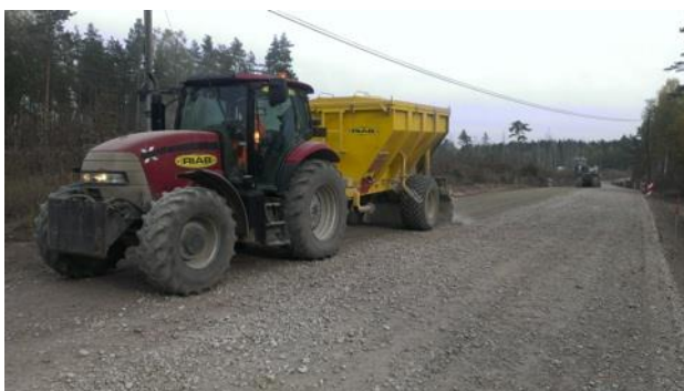
6-16 attēls. Cementa izbēršana
