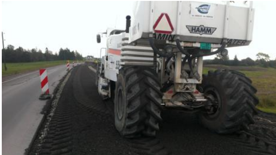
6-9 attēls. Materiāla kārtu samaisīšana un cementa iemaisīšana ar recikleru
