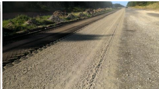
6-2 attēls. Cementa izbēršana.
