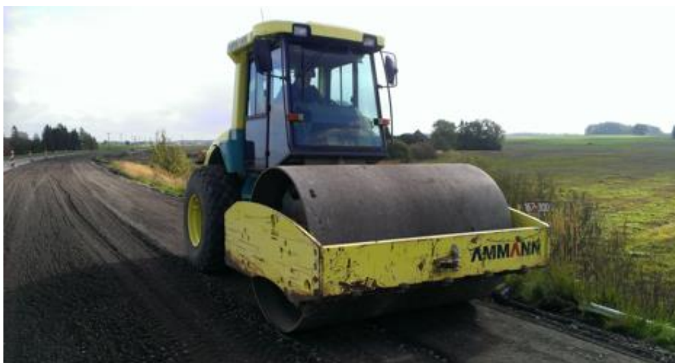
6-11 attēls. Reciklētās kārtas blīvēšana
