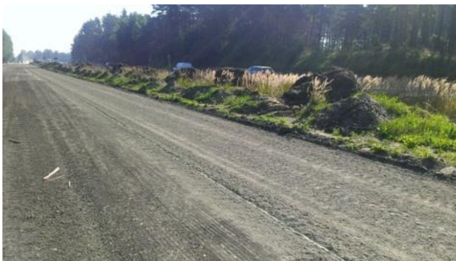
6-1 attēls. Sagatavota reciklējamās kārtas virsma.
