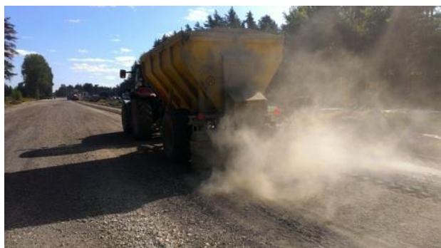
6-2 attēls. Cementa izbēršana.
