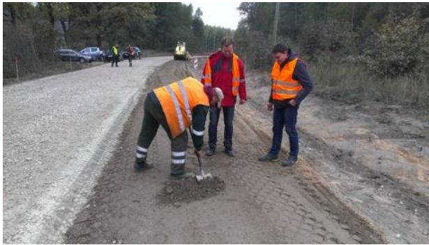
6-18 attēls. Šurfēšana un reciklētās kārtas biezuma uzmērīšana
