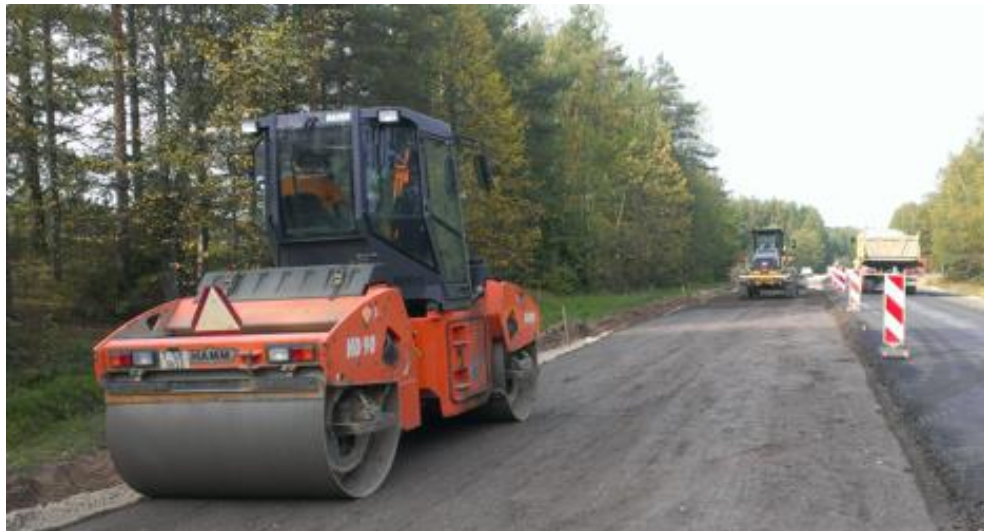
6-13 attēls. Apakšējās kārtas sablīvēšana
