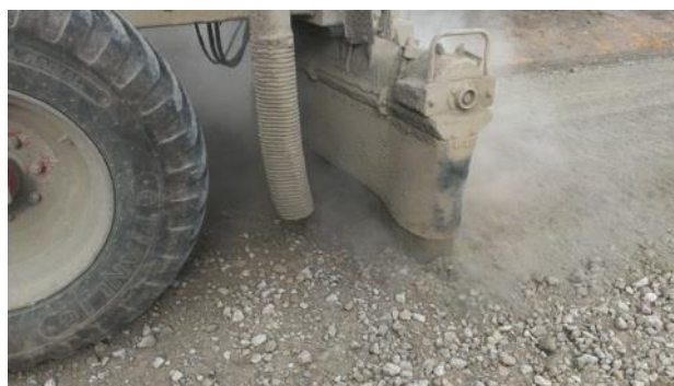
6-16 attēls. Cementa izbēršana
