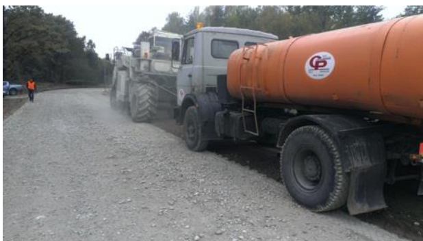
6-17 attēls. Reciklēšana ar ūdens pievienošanu un pieblīvēšana
