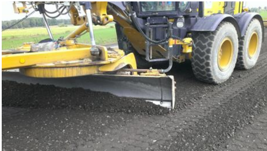
6-10 attēls. Reciklētās kārtas profilēšana ar autogreideri
