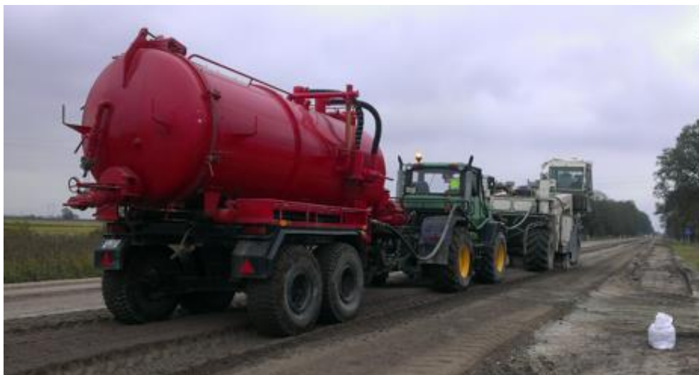
6-5 attēls. Materiāla kārtu samaisīšana un cementa iemaisīšana ar recikleru
