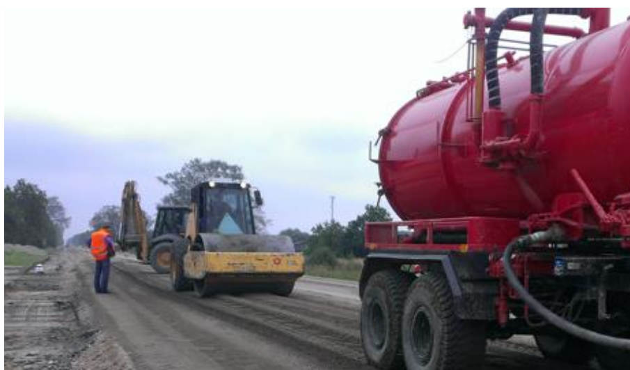
6-6 attēls. Samaisītās kārtas nekavējoša pieblīvēšana ar veltni
