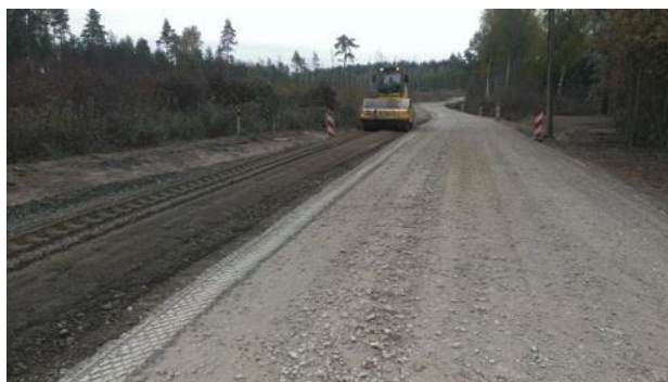
6-17 attēls. Reciklēšana ar ūdens pievienošanu un pieblīvēšana
