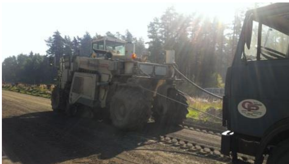
6-3 attēls. Reciklera gājiens (iemašot cementu, ar ūdens pievienošanu).
