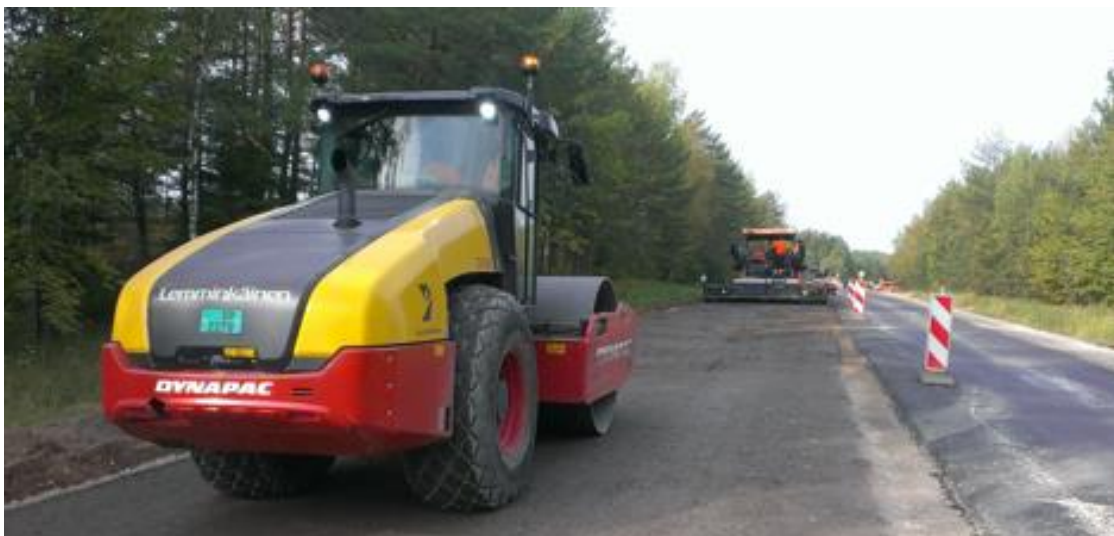
6-15 attēls. Augšējās kārtas sablīvēšana
