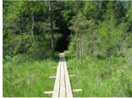
34.att. Izbūvēta jauna laipa, lai apmeklētāji var šķērsot purvu (2013) 17
