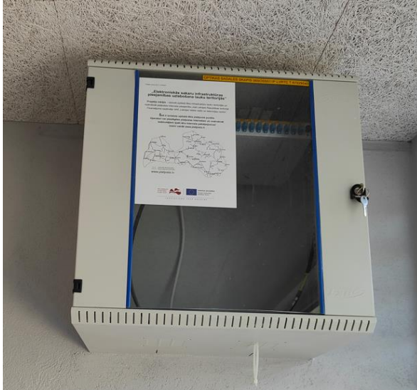
2.1. Optisko šķiedru kabeļu iekštelpu sadales skapis
