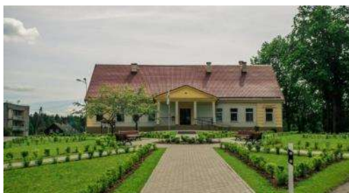
22.att. Launkalnes pagasta apvienības pārvalde, Launkalnes tautas nams un bibliotēka, Ezera 2A, Launkalne, Launkalnes pagastā.
