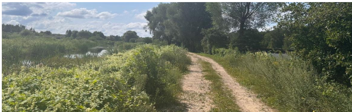
51.attēls Zeduļu dambis (2024.gada jūlijā)
