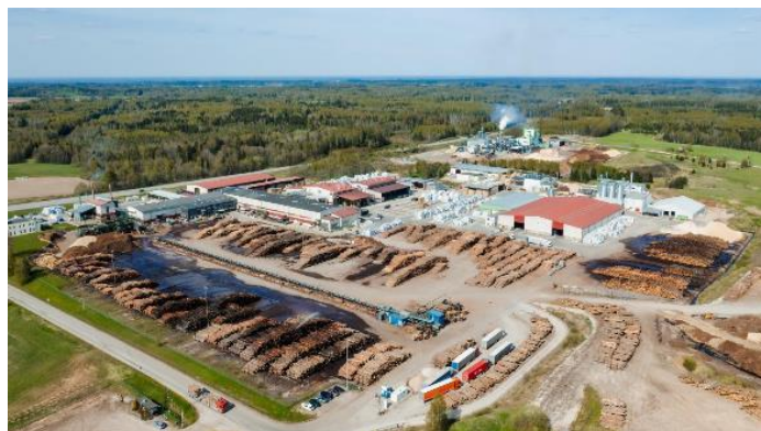
25.att. Launkalnes kokzāģētava AS „Stora Enso Latvia”.
