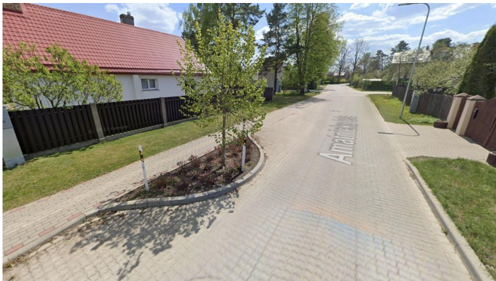
33. attēls. Brauktuves telpas sašaurinājuma piemērs Amatnieku ielā, Ogrē. Avots: „Google”
