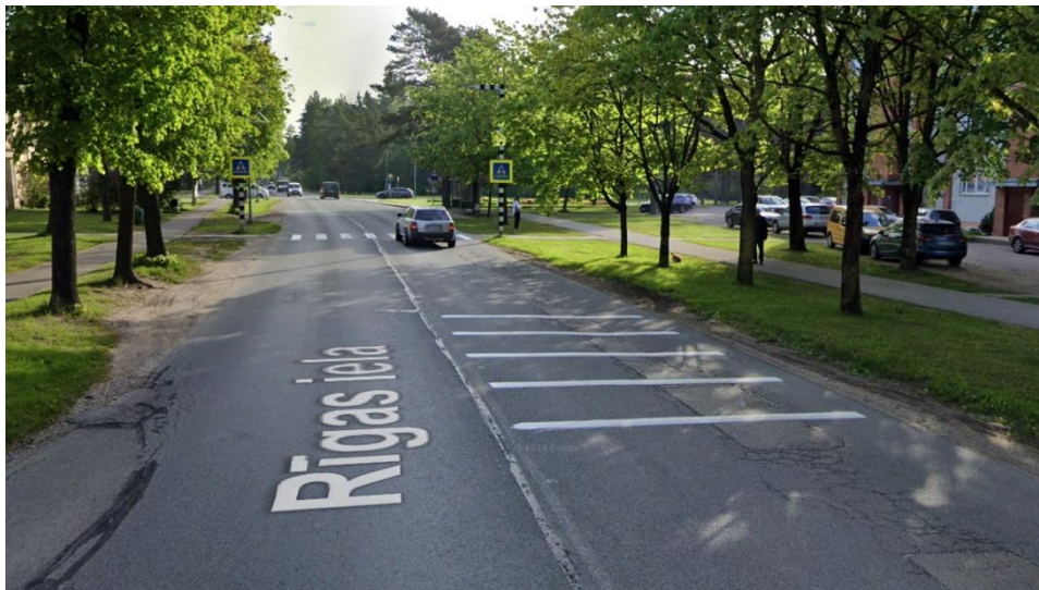
23. attēls. Brīdinošas joslas pirms gājēju pārejas Rīgas ielā, Baložos. Avots: „Google”
