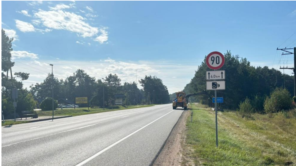
26. attēls. Ceļazīmes par vidēja ātruma kontroli uz autoceļa A1 Lilastē. Avots: „IE.LA inženieri”
